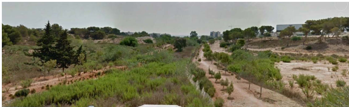
Estado actual de la Cañada Hermosa tras las labores de encauzamiento.
